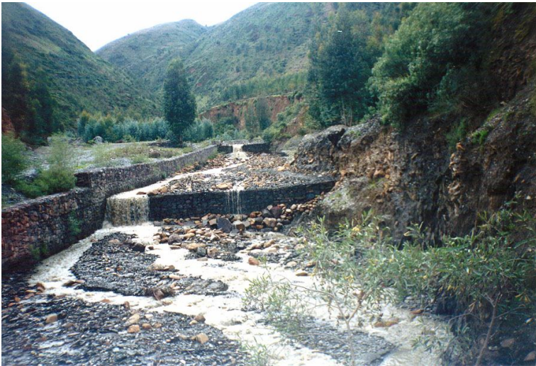
Foto 7: El encauzamiento del río Chupanhuauro con gaviones y muros secos es una de las acciones mas relevantes que permiten controlar los huaycos de manera conjunta con lo diques . A pesar de no haber sido realizada por el proyecto es un complemento a considerar
