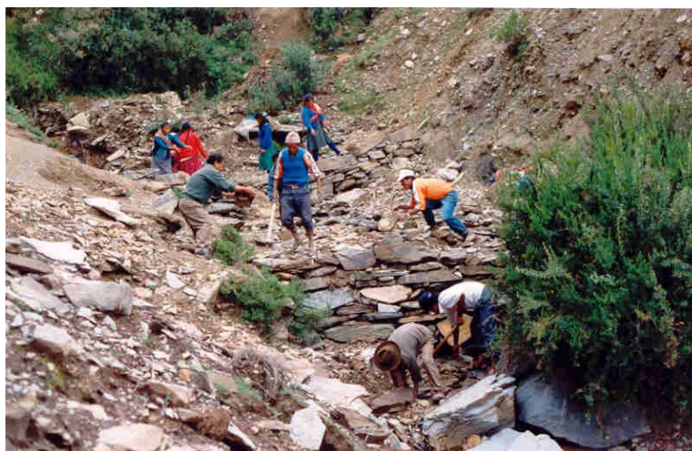
Foto 4: Proceso de construcción de muros de piedra a lo largo de cárcava con problemas de deslizamientos bajo la dirección del residente
